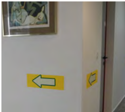
Odsevne in svetleče oznake evakuacijske poti, nameščene nižje, so dobro vidne tudi ob zadimljenosti prostora.
