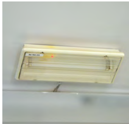
Varnostna razsvetljava zagotavlja ustrezno vidljivost za varen umik iz prostora ob izpadu električnega napajanja objekta.
