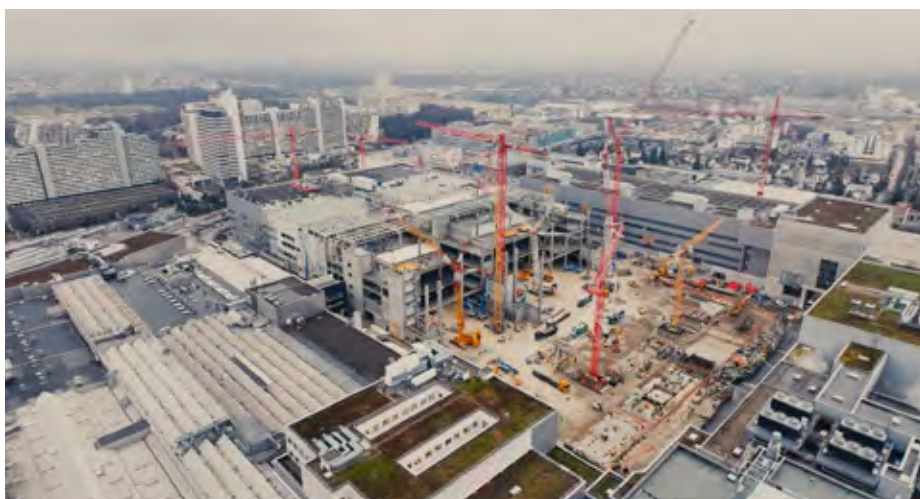
Prikaz izgradnje novih proizvodnih prostorov. (Vir: BMW group, 2025)
