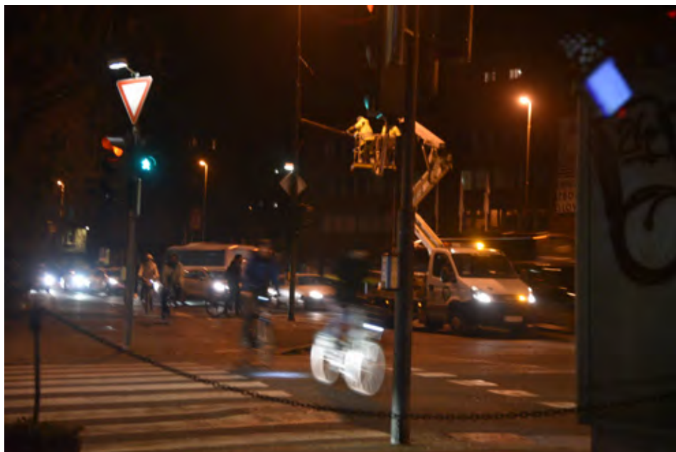
V pripravah pred začetkom prevoza so delavci umakniti nadcestne semaforje, na poti pa so umikali tudi transparente in kable preko ceste.
