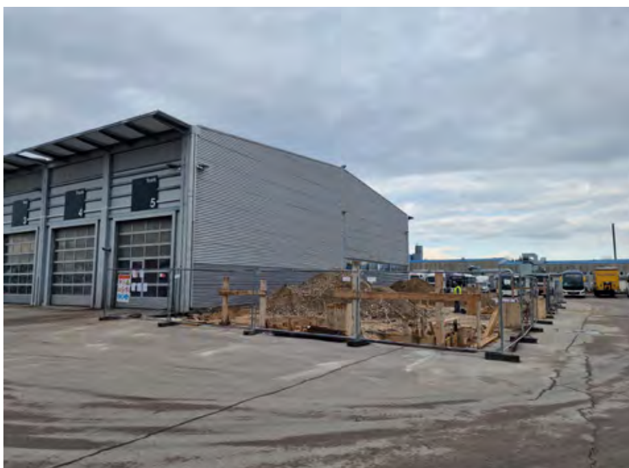
Prostor, kjer bosta potekali širitev delavnice in gradnja električnih polnilnic.
