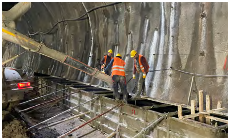
Betoniranje temeljev notranje obloge predora.
