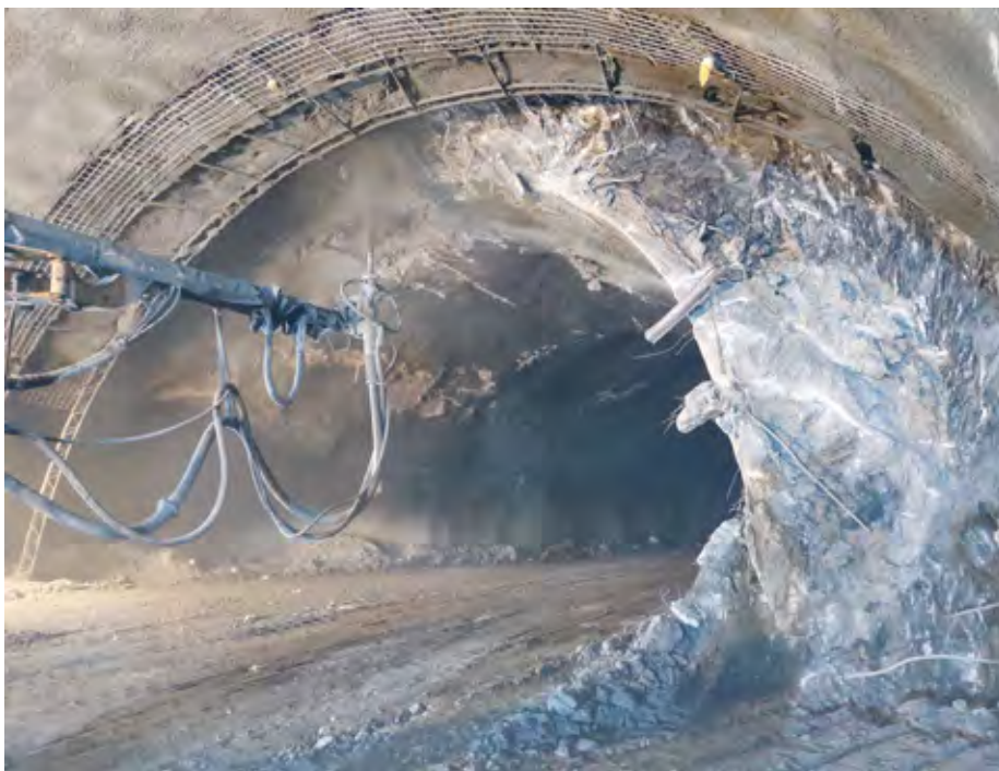
Vrtanje vrtin za miniranje na čelu predora.
