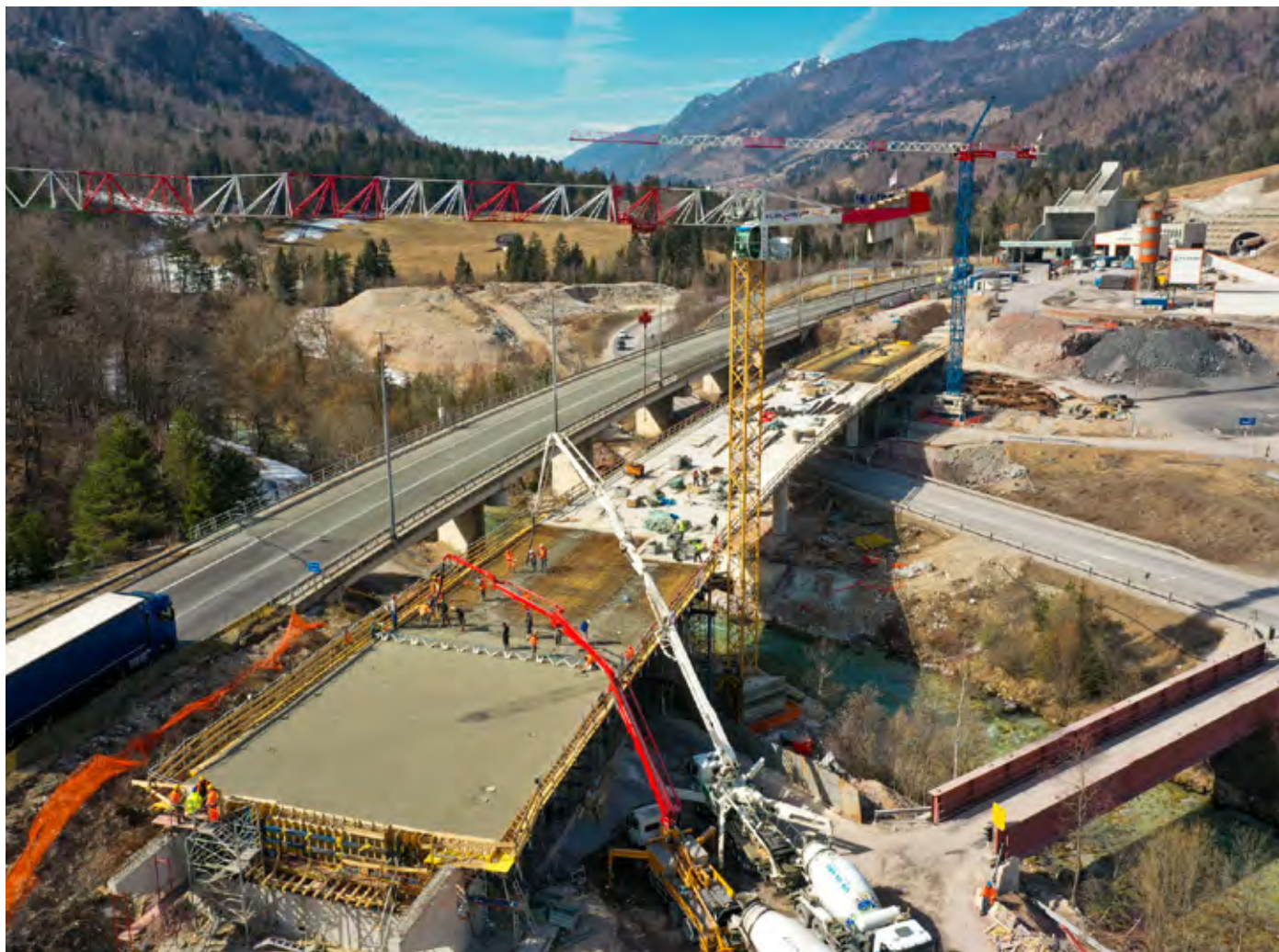
Betoniranje mostu M-1 (165 m), kot del manjkajoče AC povezave.
