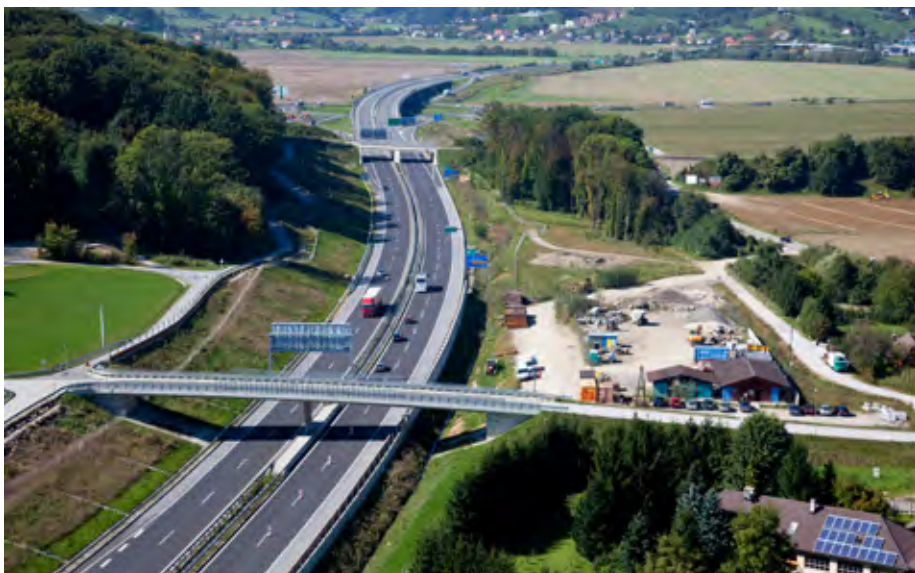
S študijo so ugotovili, da bo treba do leta 2040, na slovenskem avtocestnem omrežju, zagotoviti 1.200 dodatnih parkirišč za tovorna vozila.
