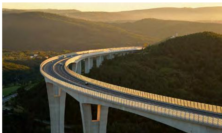
Po oceni DARS-a je prepoved prehitevanja za tovorna vozila prispevala k večji varnosti in pretočnosti prometa na slovenskih avtocestah in hitrih cestah. Tovorna vozila s prehitevanjem namreč ne zavirajo več prometnega toka na prehitevalnem pasu.
