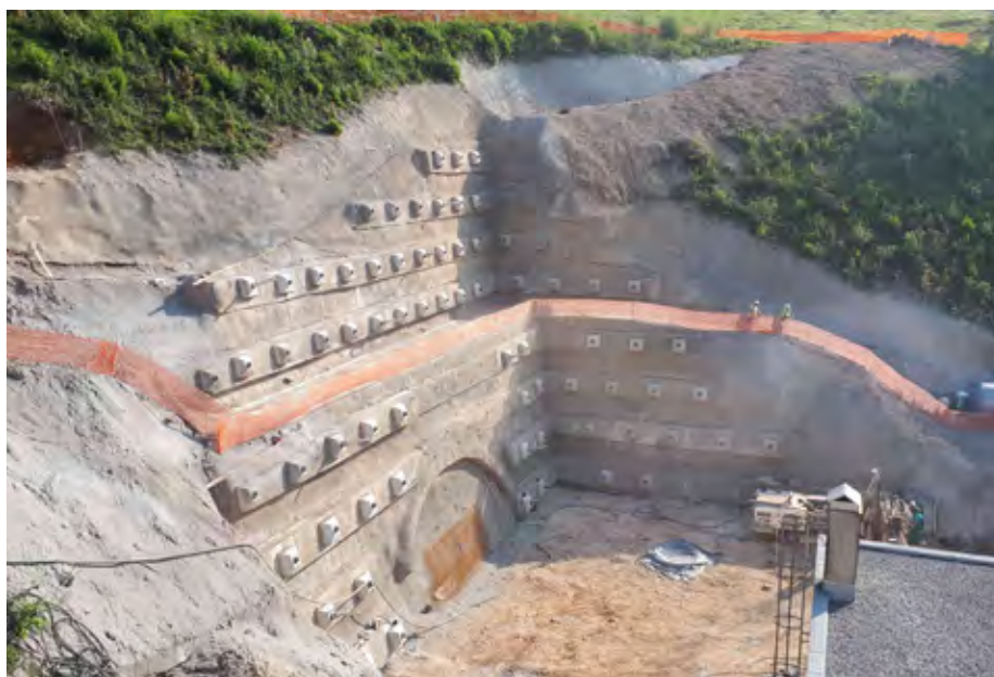
Pripravljena površina za začetek kopanja tunela.
