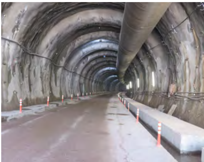
Izkopani del, pripravljen na dodatna dela in finalizacijo.
