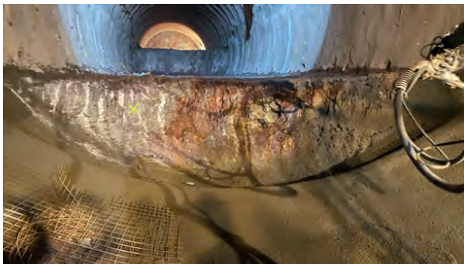
Zaključek primarne obloge v celotnem profilu predora.
