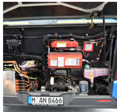
Avtobus je opremljen z gasilnim sistemom, baterije pa so v celoti nameščene na strehi.
