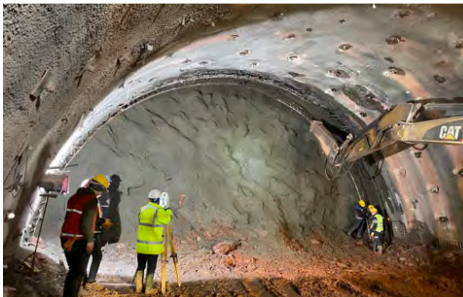
Vgradnja paličnega loka v notranjo oblogo predora v kaloti.
