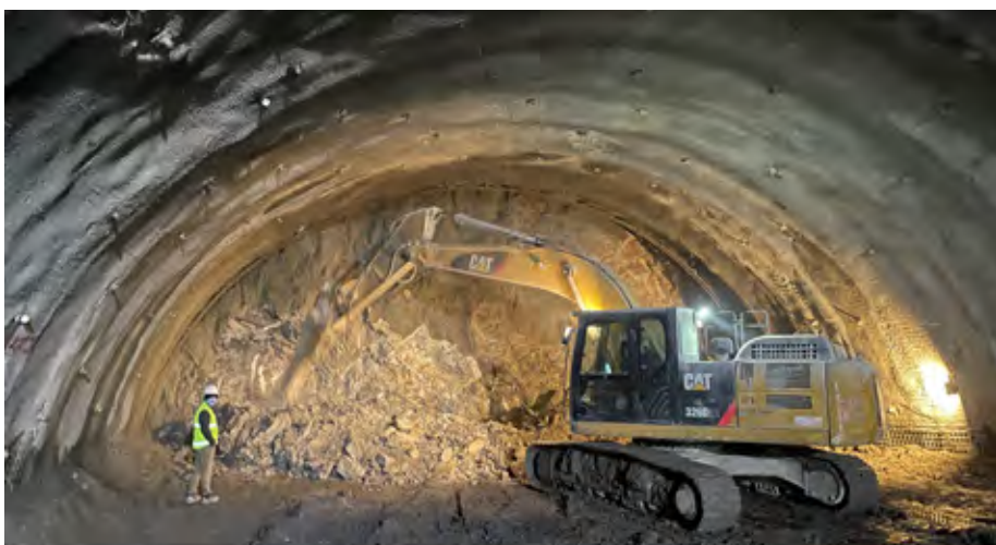
Izkop z bagrom v stropnici.
