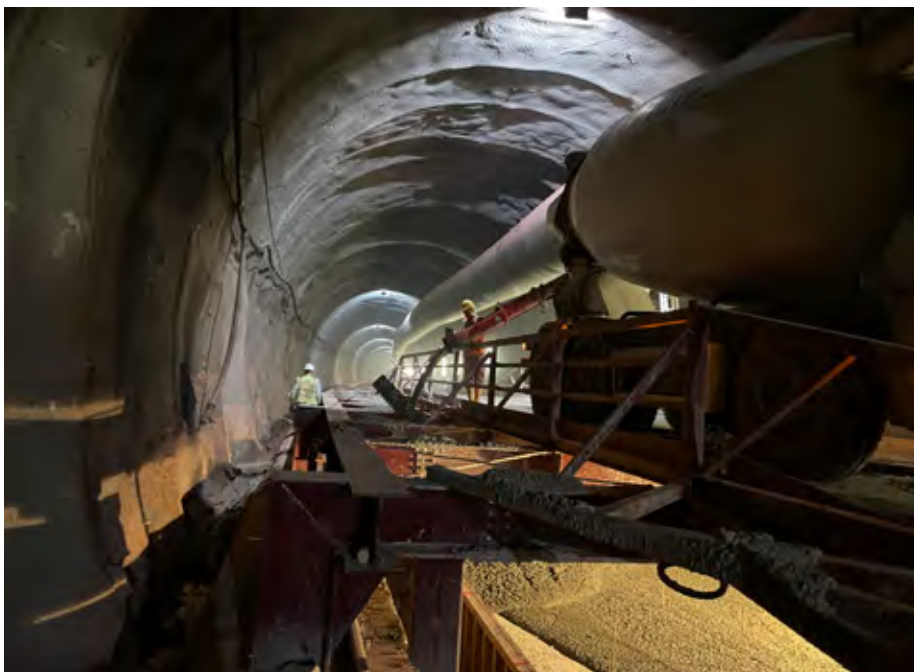
Betoniranje talnega oboka iz litega betona s premične mostne konstrukcije.
