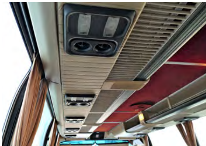
Potniki se dobro počutijo tudi zaradi dobrega zračenja in klimatske naprave, ki jo je srbski lastnik naknadno vgradil.
