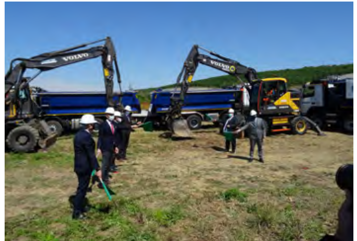
Simbolični začetek gradbenih del 2TDK 5. maja 2021 v Dekanih.
