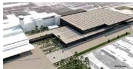
Nov terminal na brniškem letališču bodo predvidoma odprli leta 2020. Foto: Fraport
