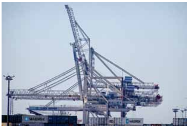
Kontejnerska dvigala v Kopru (Foto: Orbanic 2018)
