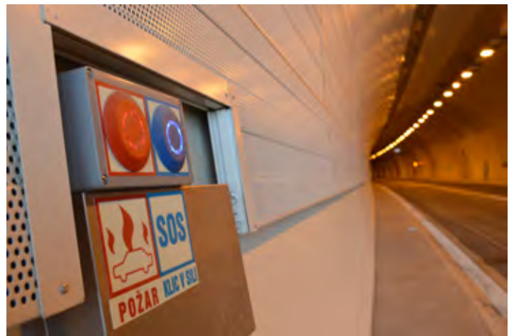
Javljalniki omogočajo takojšno proženje alarma v nadzornem centru in hitro intervencijo reševalnih enot.
