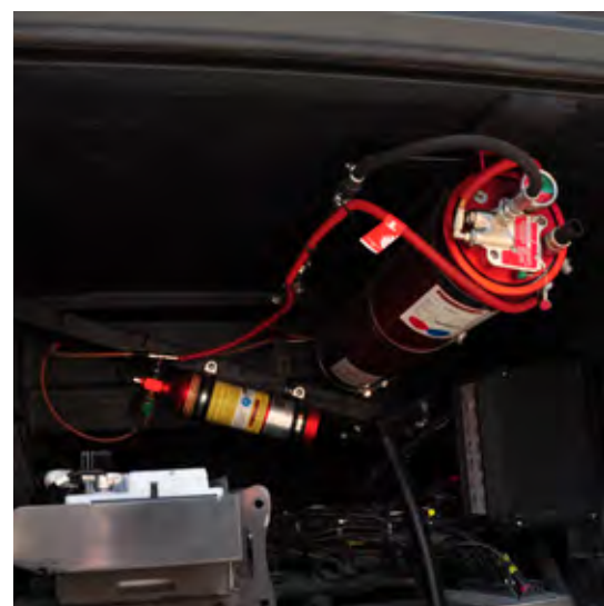
Samodejni gasilni sistem pomaga varno in hitro pogasiti začetni požar. Poskrbeti pa je treba da je sistem v brezhibnem stanju.
