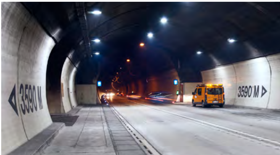
Predori so praviloma opremljeni z oznakami o oddaljenosti izhoda ter pogosto tudi z evakuacijskimi prehodi v vzporedni servisni ali reševalni predor.
