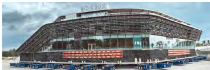
Samohodne transportne platforme SPMT so bile usmerjene pod različnimi koti, s čimer je nastala transportna platforma v obliki pahljače.
